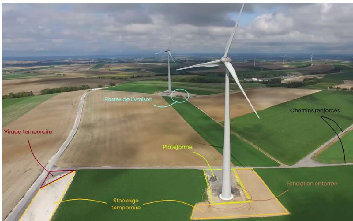
Figure 18 : Aménagements d’un parc éolien (Parc éolien du Nitis 1&2 – Réalisation : Renner Energies)
